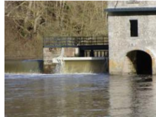
Vue de l'aval et de la VLH
