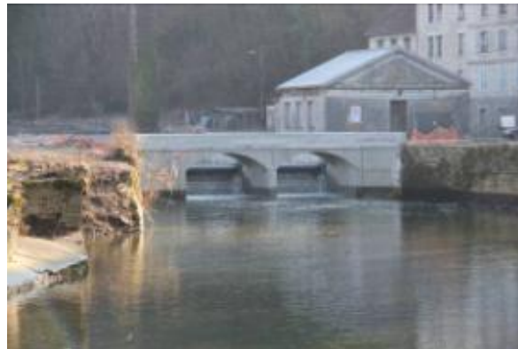
Vue aval des 2 VLH DN 4000
