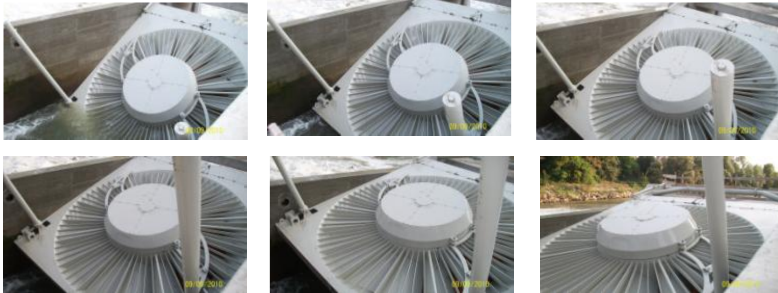
Relevage Hydraulique de la VLH de Montodine (Italie)
