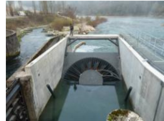
Vue de l'amont VLH installée
