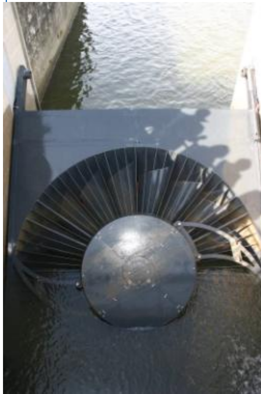
VLH hors d'eau vue amont
