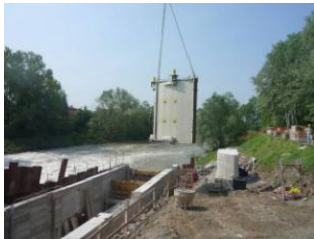
Mise en place des vannes verticales
