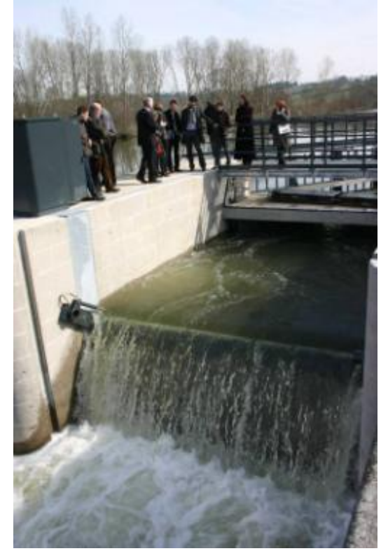
Vue de l'aval et de la VLH
