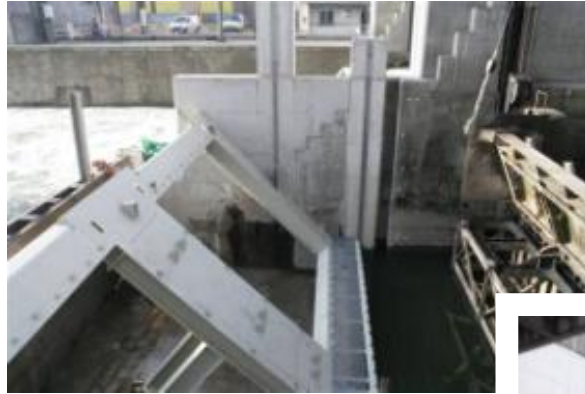
Installation des VLH dans la structure portante
