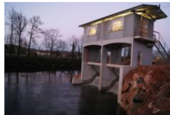
Vue amont et aval de la nouvelle Centrale équipée 2 VLH DN 4000
