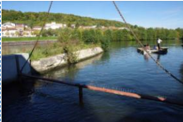
Dispositif de récupération
