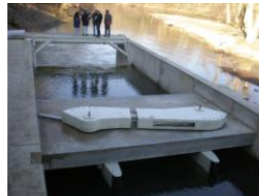
Vue de l'amont avec vannes à pivotement vertical
