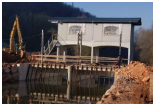
Vue amont et aval de la nouvelle Centrale équipée 2 VLH DN 4000
