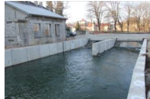
Vue de l'amont des VLH et du bâtiment de la Centrale
