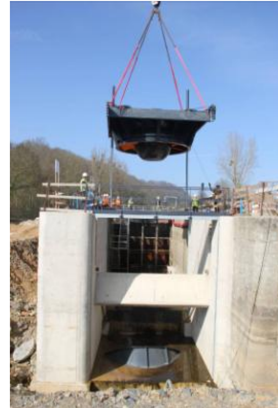
1 er Grutage du projet de 14 VLH sur la Mayenne pour SHEMA
